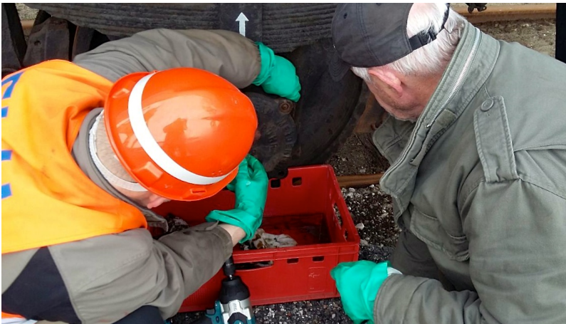
Nach erneuter Sturmflut im Oktober 2017 müssen nun alle Lager geöffnet und ent
