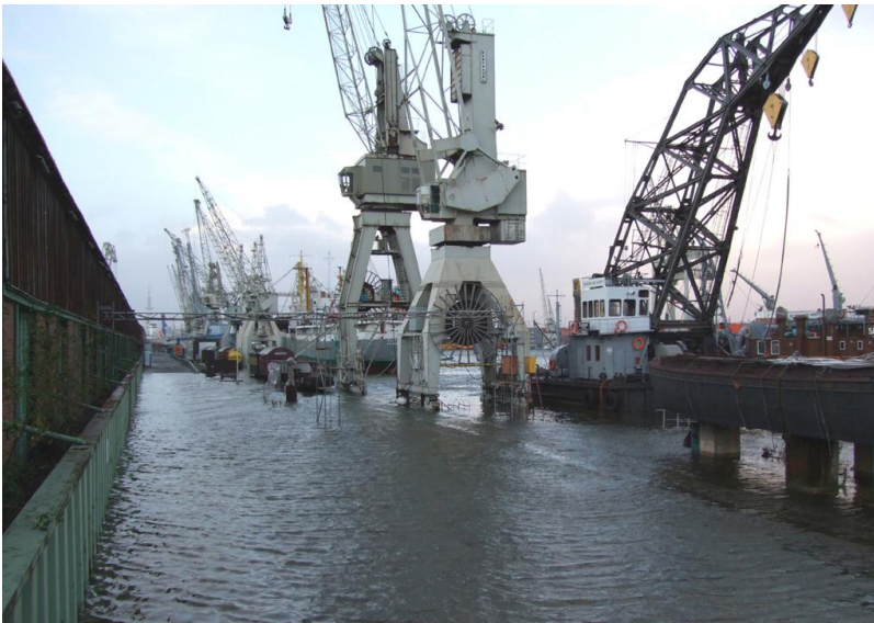
Sturmtief Tilo beschert uns am Bremer Kai Hochwasser, unsere Gleise liegen aus 09.11.2007
