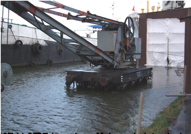
09.11.2007 Unserer Schienenkran Mainz scheint schwimmen zu können
