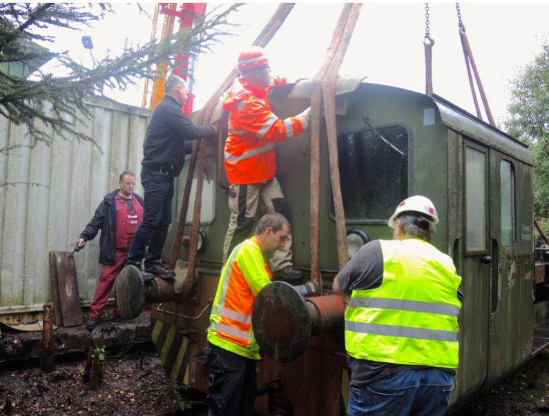
Die Schwerlastgurte wurden angelegt
