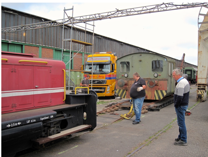
...die Gleisrampe montiert...
