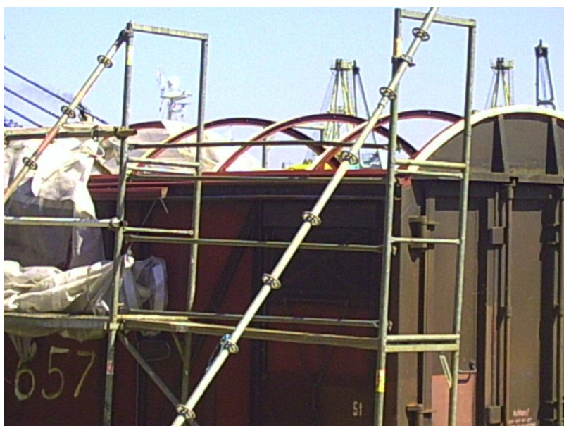
Erneuerung der Dachbeplankung
