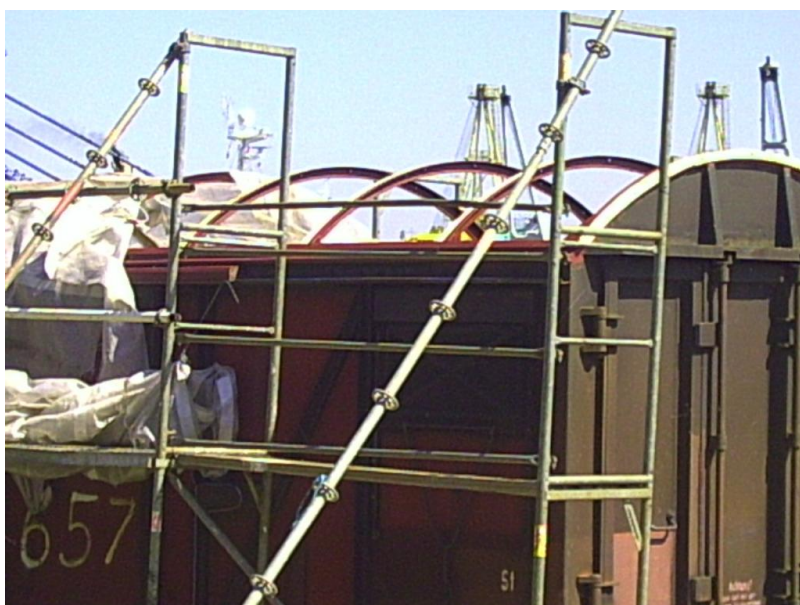
Erneuerung der Dachbeplankung
